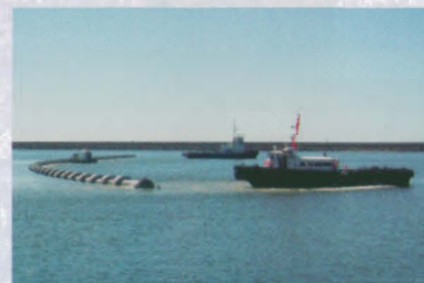
Instalación del emisario de Mar del Plata
